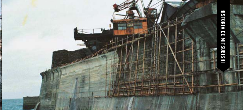
Rompeolas incluido en el Patrimonio Mundial. En fase de restauración, por lo que está al descubierto la mampostería de piedra con arcilla roja y cal como adhesivos (método conocido como «Amakawa»).
